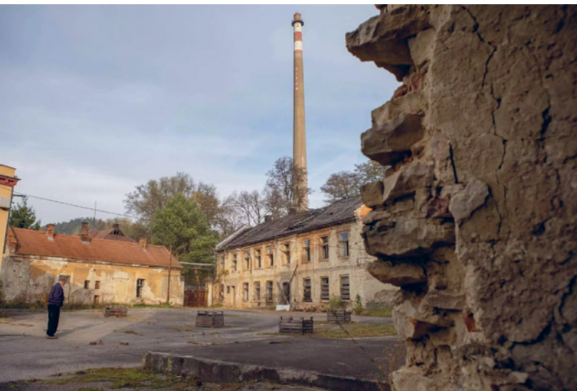
Areál bývalé továrny Löw-Beerů v Brněnci, známá i jako Schindlerova. Budovy jsou v dezolátním stavu – okna rozbitá, cihlové zdi se rozpadají a na některých místech ze sutin vyrůstají stromy. Některé už jsou i několik metrů vysoké / Foto: Karolína Poláčková
